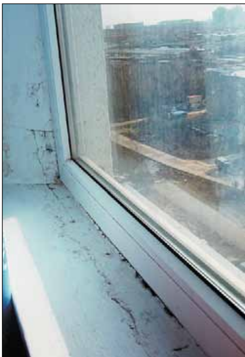
Плесень на подоконнике с плохо установленным стеклопакетом.
